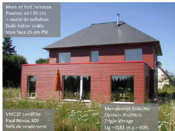
Figure 19 : Vue de façade d'une maison passive individuelle labellisée en Normandie, avec caractéristiques principales
